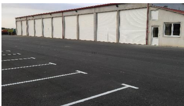
Sl. 15. Garaže u reciklažnom dvorištu
