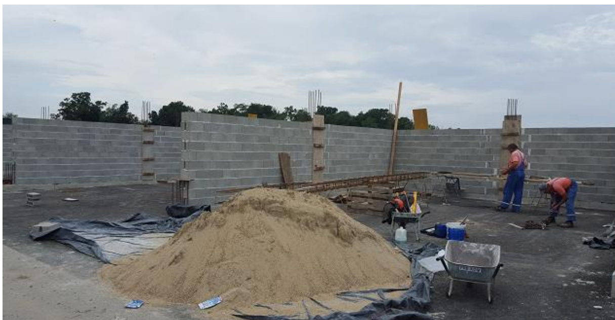
Sl. 26. Izgradnja natkrivenog skladišta za balirani korisni otpad
