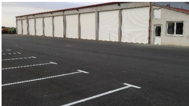
Sl. 16. Garaže u reciklažnom dvorištu
