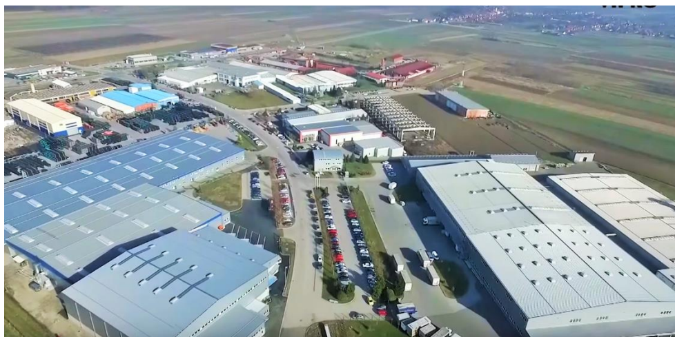
Slika 5: Solarni potencijal krovova poduzetničke zone Grada Preloga, Zona Istok
