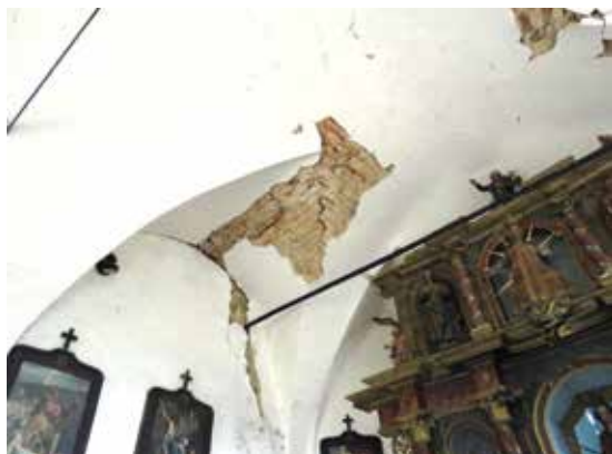
Lenišće, Kapela sv. Margarete, oštećenja u unutrašnjosti kapele zadobivena u potresima 28. i 29. 12. 2021.
