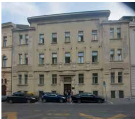
Kuća broj 12 na zagrebačkom Mažurancu
