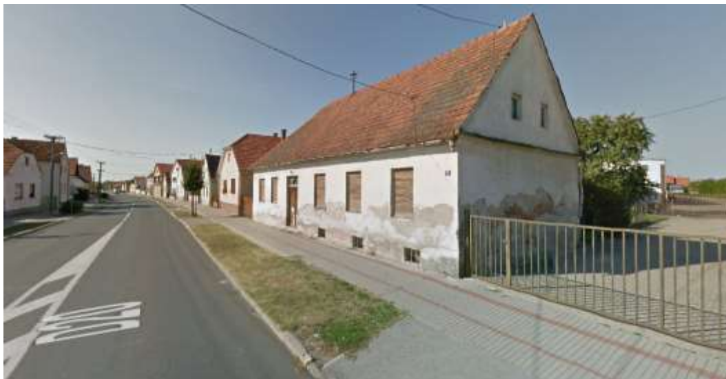
Prikaz 3 Čakovečka ulica - pogled na zapad
