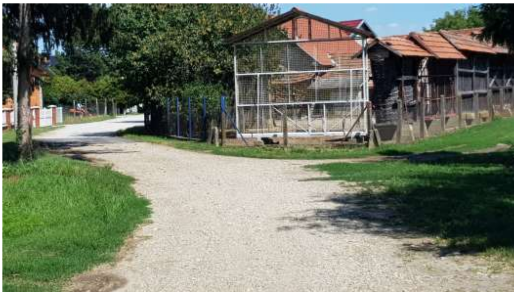
Prikaz 7 Završetak asfaltiranog dijela ceste odvojka Čakovečke ulice
